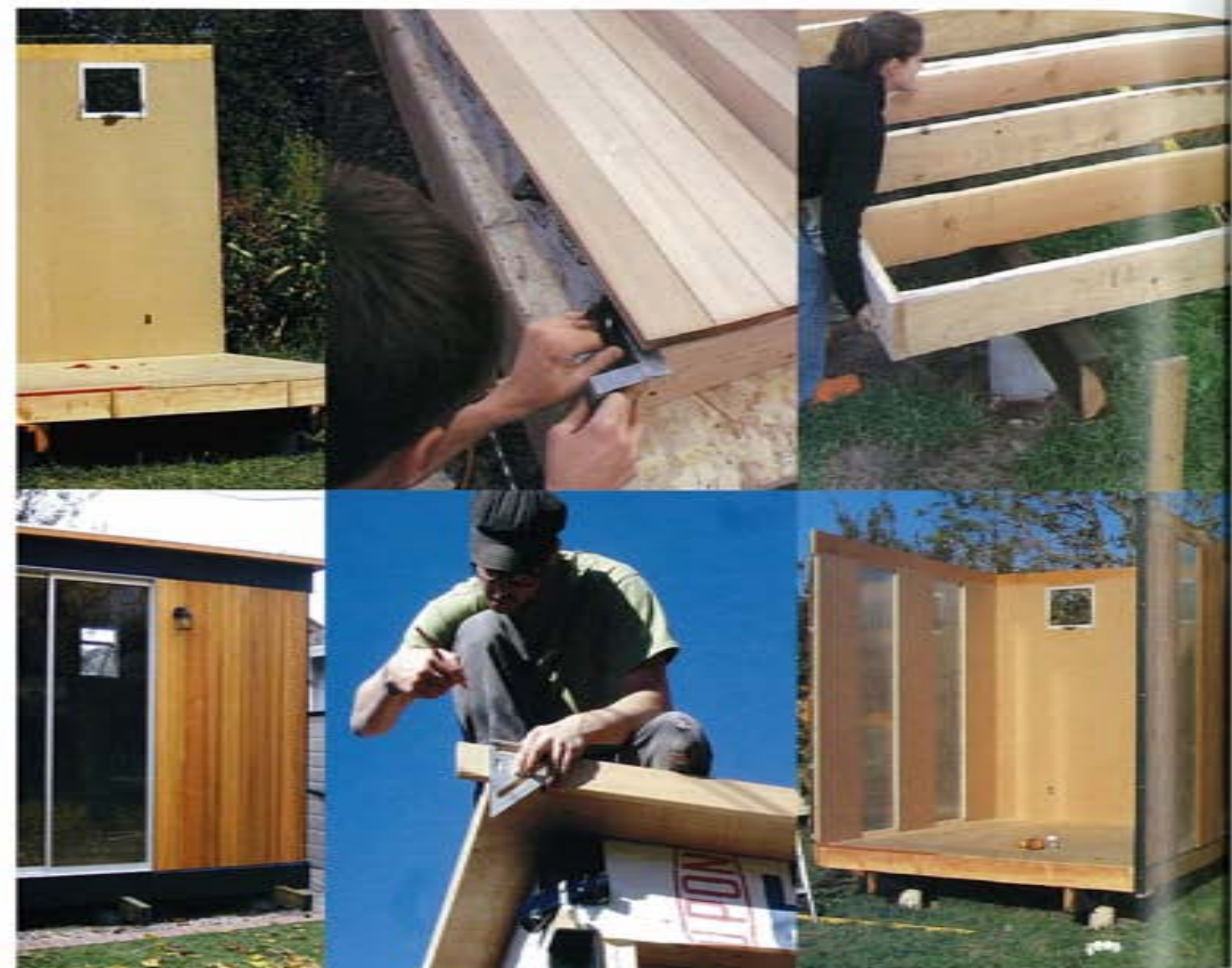
クリートのブロックを四隅に配置するだけなので、大がかりな基礎工事は不要。その上に防腐処理した横木を渡す。これが床を支える部位になるので、水準器を使ってしっかりと水平を取って組立て済みのプラットフォームを置く。ここでも再度、水平を確認してから床板をはる。窓を取りつけてある奥の壁を立ち上げる。左右の壁を取りつければ、仮支えをしておく。下段はめこみ込みの左右の壁を立ち上げる。屋根を載せる。この屋根の水切り配は、あらかじめ取られている。正面入口のVパネルは、ドアのスタイルによって複数のパターンが用意されている。誰でも何人かの手があれば建てられる。Modern Cabana, 602 Minnesota St., San Francisco CA 94107, USA, Phone +1 415-206-9330, http://www.moderncabana.com/
